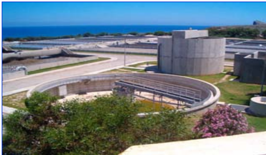
Photo 5 : Station d'épuration des eaux usées de la ville d'Al Hoceima
