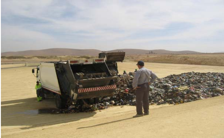
Photo 13 : Mise en décharge 1 ère cellule (Décharge contrôlée d'Oujda)
