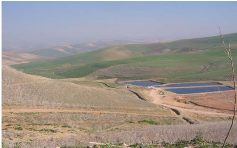
Photo 10 : Bassin de lixiviats de la décharge contrôlée de Fès
