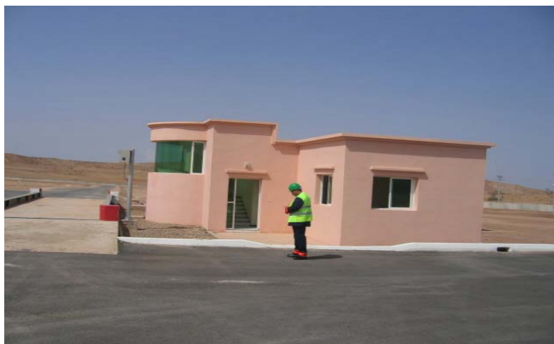
Photo 11 : Pont bascule de la décharge contrôlée d'Oujda
